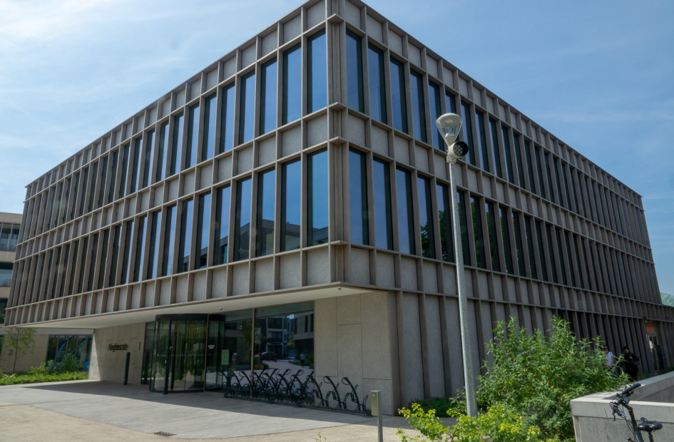
Nieuw administratief centrum en sociaal huis site Bruggeske
