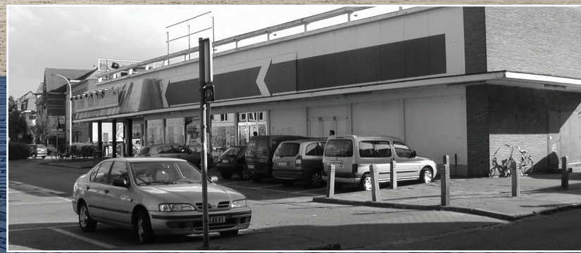
Benzinestation aan GB in centrum Kapellen
